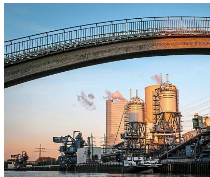
Das Kohle-Kraftwerk Datteln 4 liegt direkt am Dortmund-Ems-Kanal.
